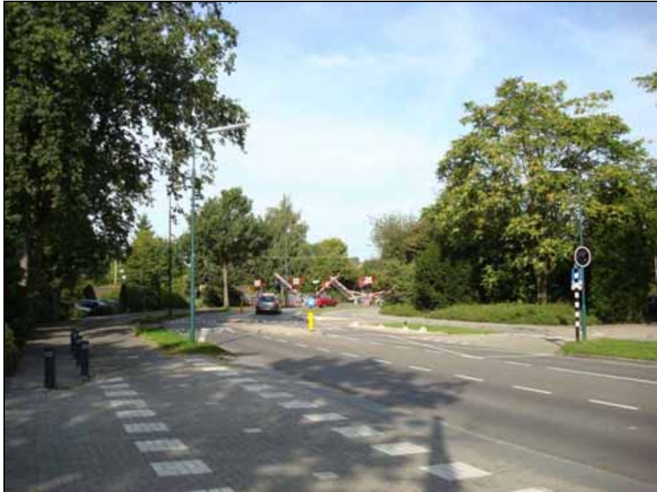
Overweg gezien vanuit de richting Spoorlaan
